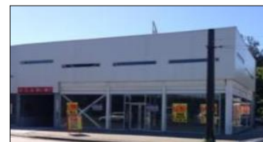
Locales comerciales en primer piso Superficie Util: 655 m² Particip. del Fondo: 100%
