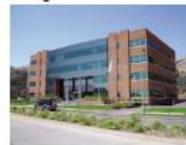
Edificio GTD Manquehue – Huechuraba
