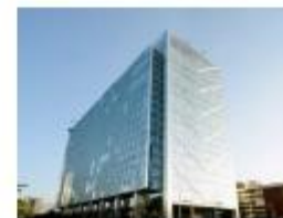
Edificio Cerro el Plomo– Las Condes
