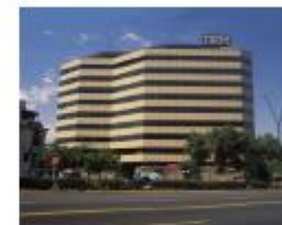
Edificio IBM– Providencia
