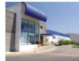
Centro Distribución APL– Pudahuel
