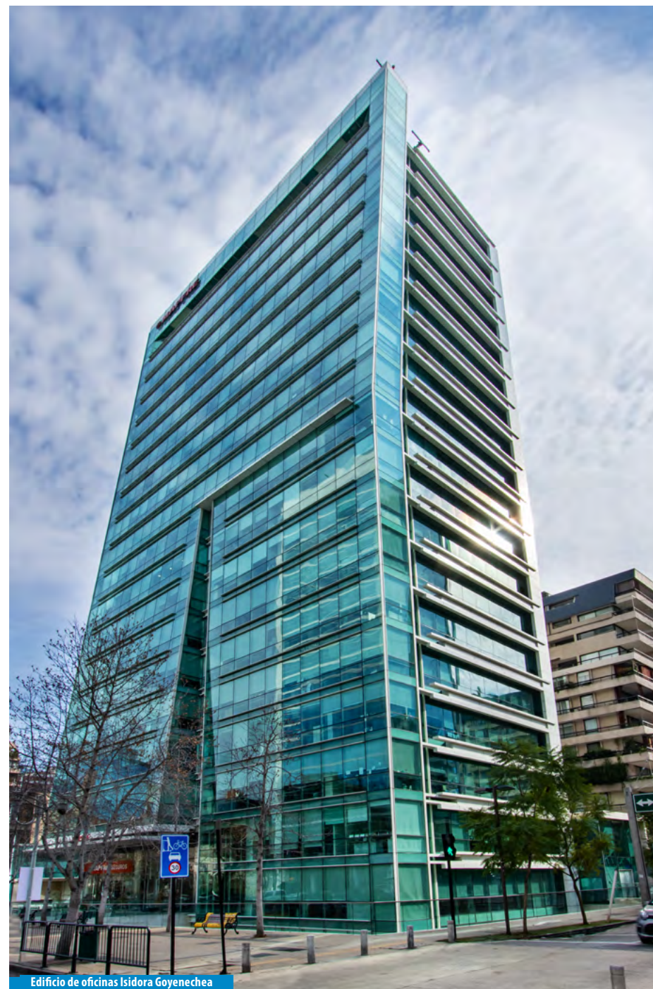
Edificio de oficinas Isidora Goyenechea
