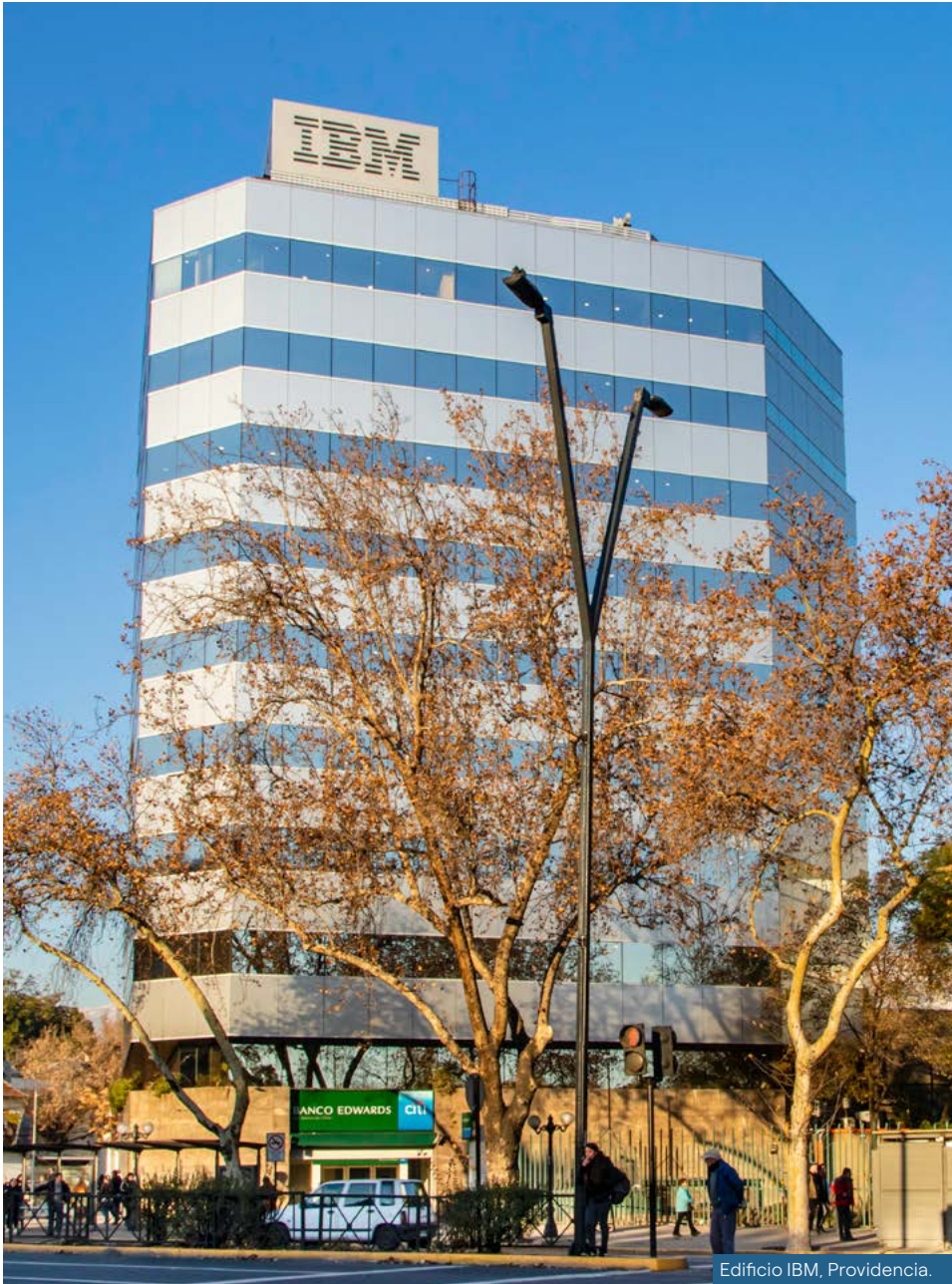
Edificio IBM, Providencia.
