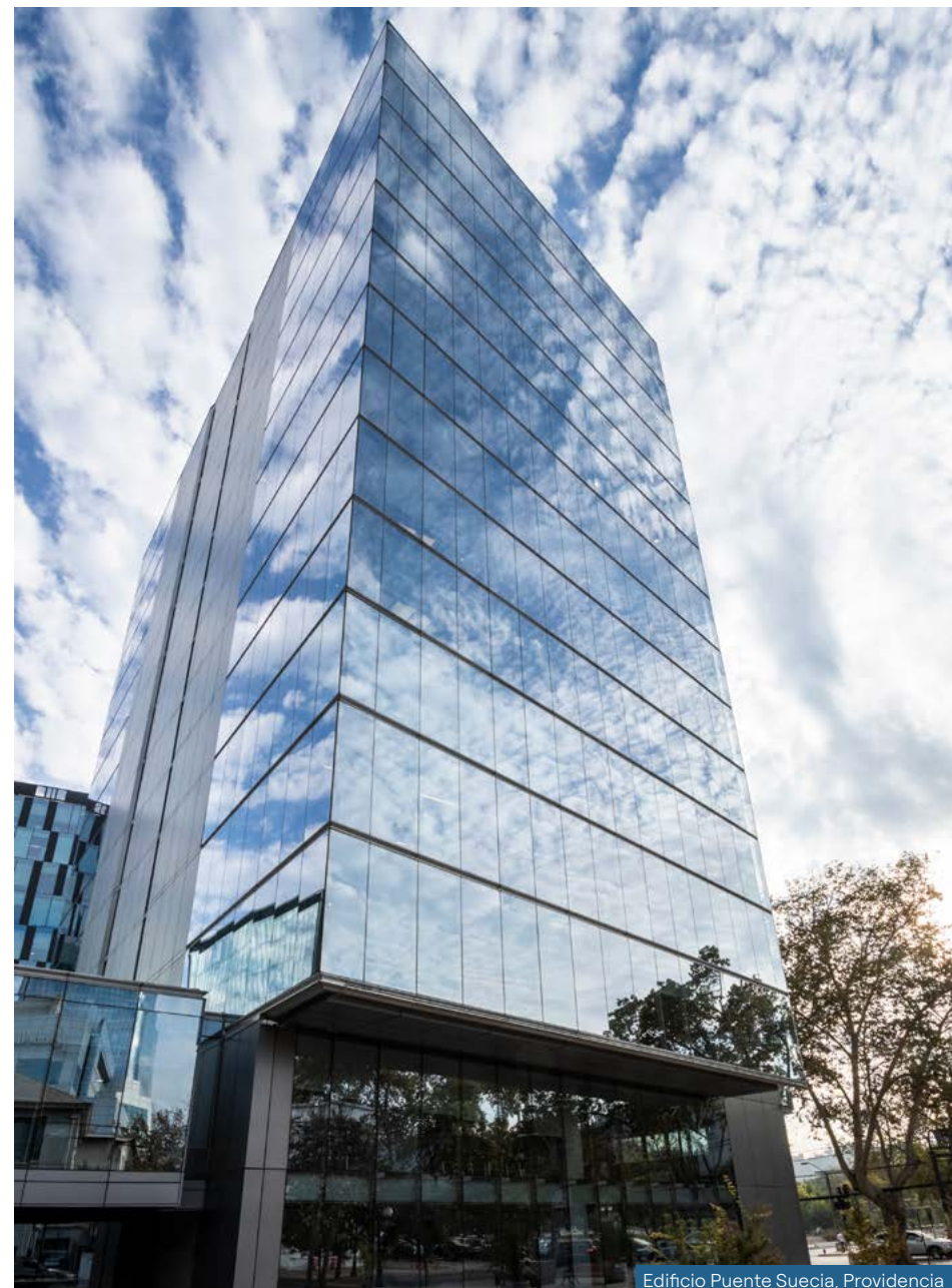
Edificio Puente Suecia, Providencia
