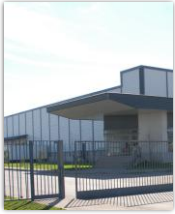
Centro de distribución La Estera - Unilever // Lampa
