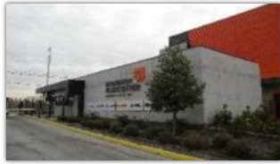
Parque logístico ENEA - Los Alerces Fase 3 // Pudahuel
