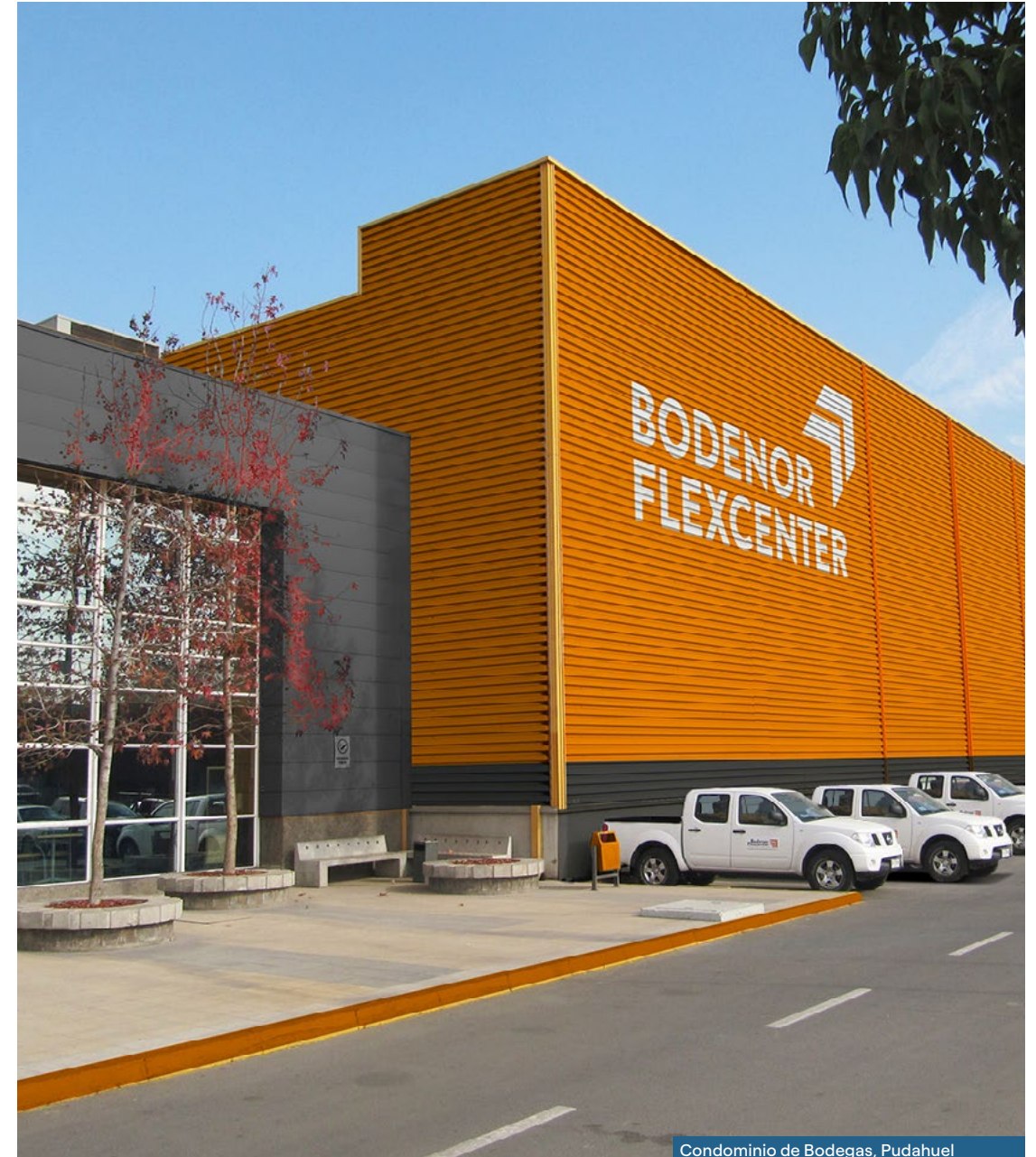
Condominio de Bodegas, Pudahuel
