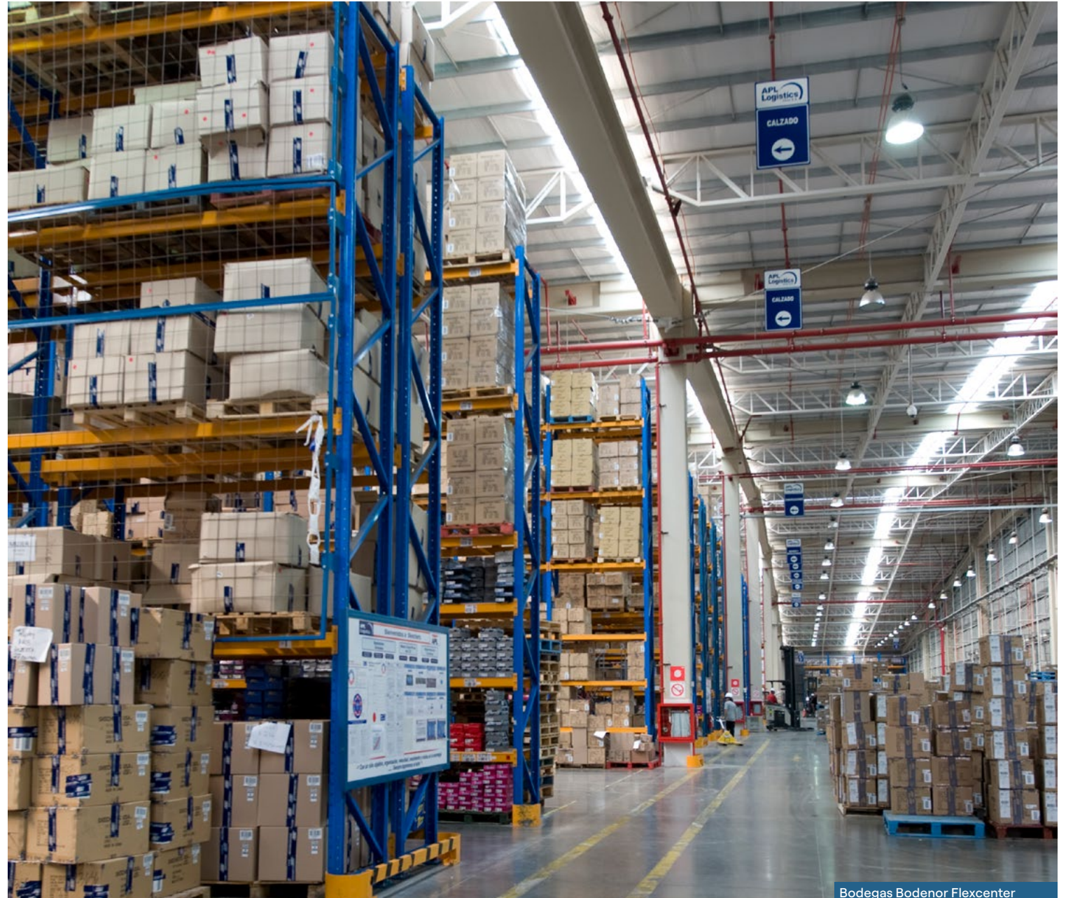
Bodegas Bodenor Flexcenter
