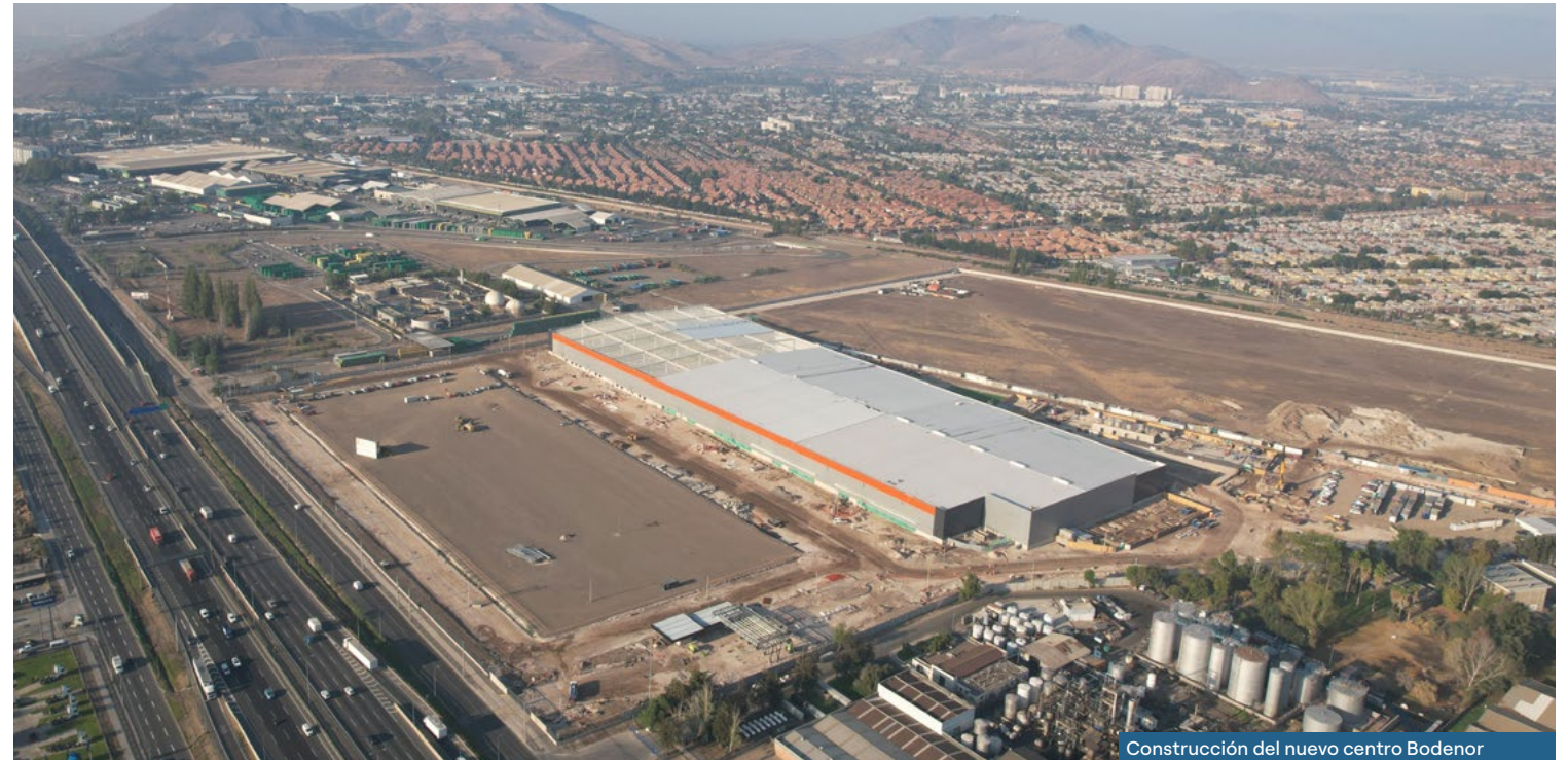
Construcción del nuevo centro Bodenor
