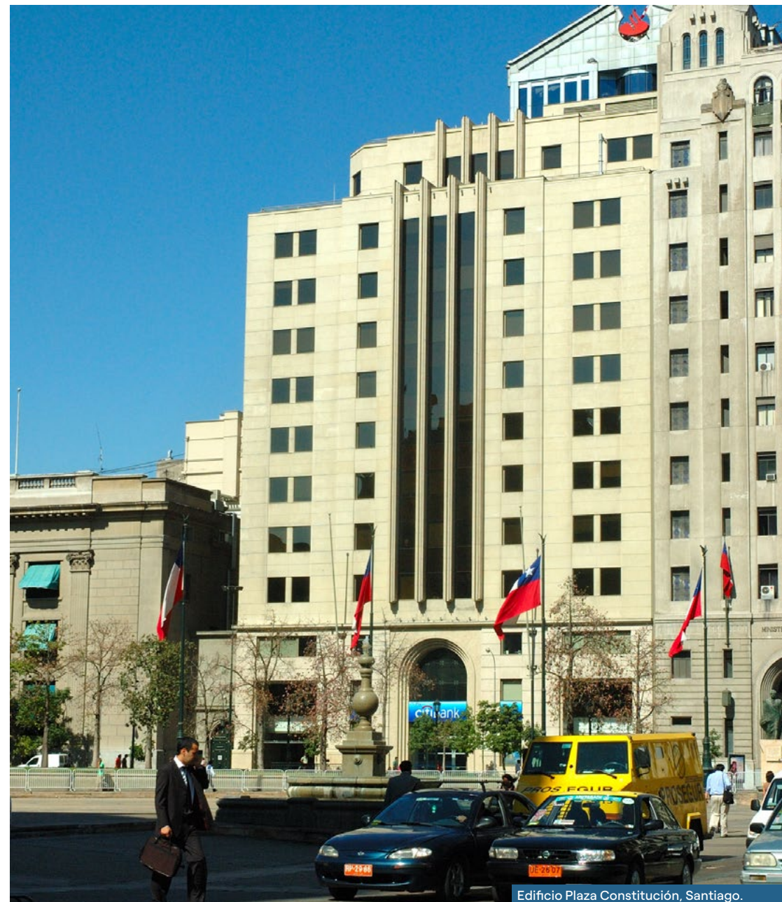
Edificio Plaza Constitución, Santiago.
