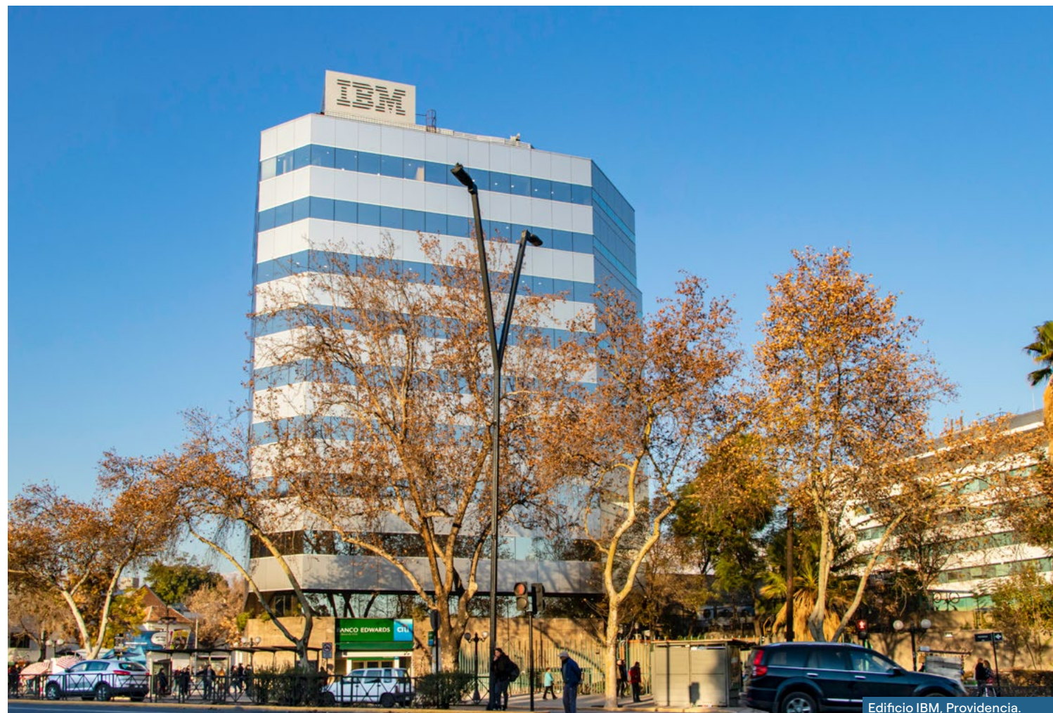
Edificio IBM, Providencia.
