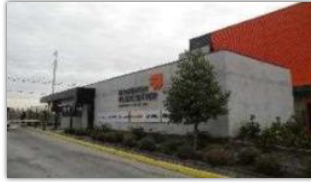
Parque logístico ENEA - Los Alerces Fase 3 // Pudahuel
